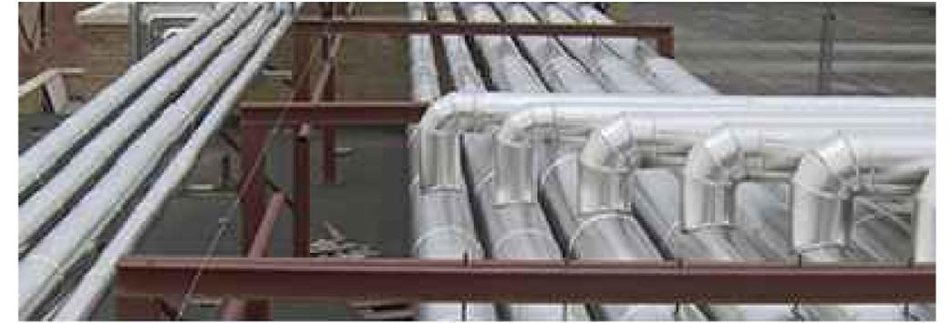
Conducto helicoidal acabado en chapa en el exterior
